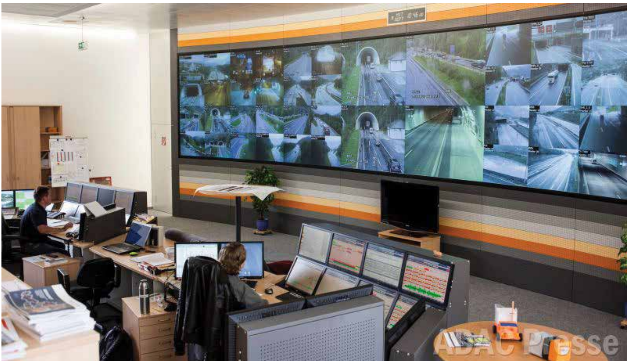
مرکز کنترل تونل Tauern همراه با پرسنل آموزش دیده
