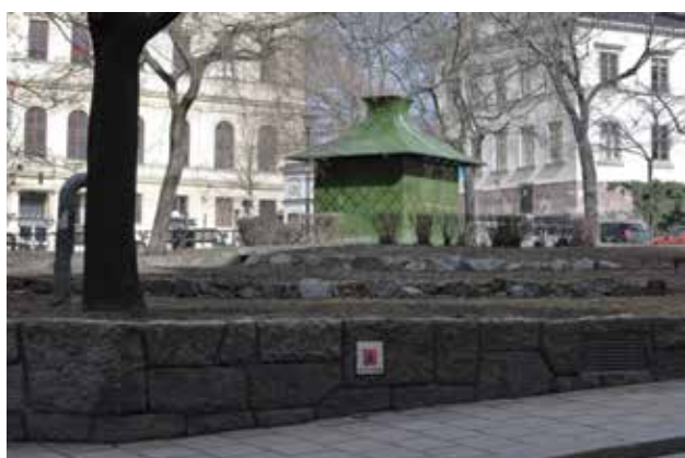
شکل ۱۱: تابلوی نارنجی در خیابان نشانگر محل ورود به پناهگاه زیرزمینی است
