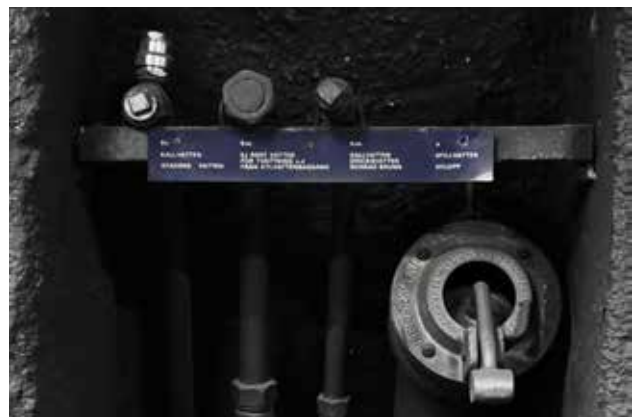
شکل ۱۴: شبکه لوله کشی آب سرد آشامیدنی و آب سرد شهر، شبکه لوله کشی آب سرد آشامیدنی از چاه آب و شبکه فاضلاب داخل تونل
