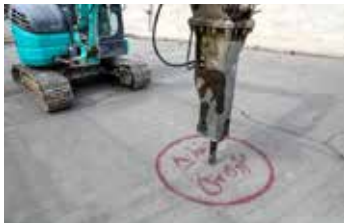
PHOTO: TEHRAN METRO عملیات اجرایی خط ۸
