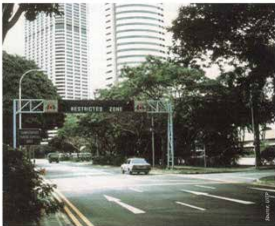
نصب تجهیزات برای کنترل ورود خودرو به ناحیه تجاری مرکز شهر سنگاپور موجب حذف ازدحام مراکز شهری و ازدحام روزانه شده است.
